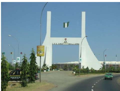
La porte d'entrée à Abuja
